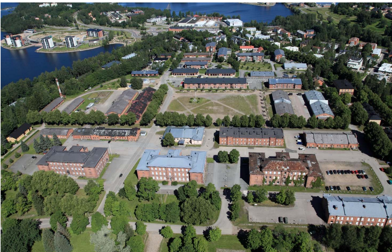
Kuva 4. Viistoilmakuva pohjoiseen 2016. Kuvan etualalla olevat kolme punatiillistä kasarmirakennusta ovat suomalaiskaudelta.
